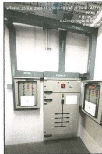
รูปภาพที่ 2.27 ตู้ควบคุมระบบบำบัดน้ำเสีย
