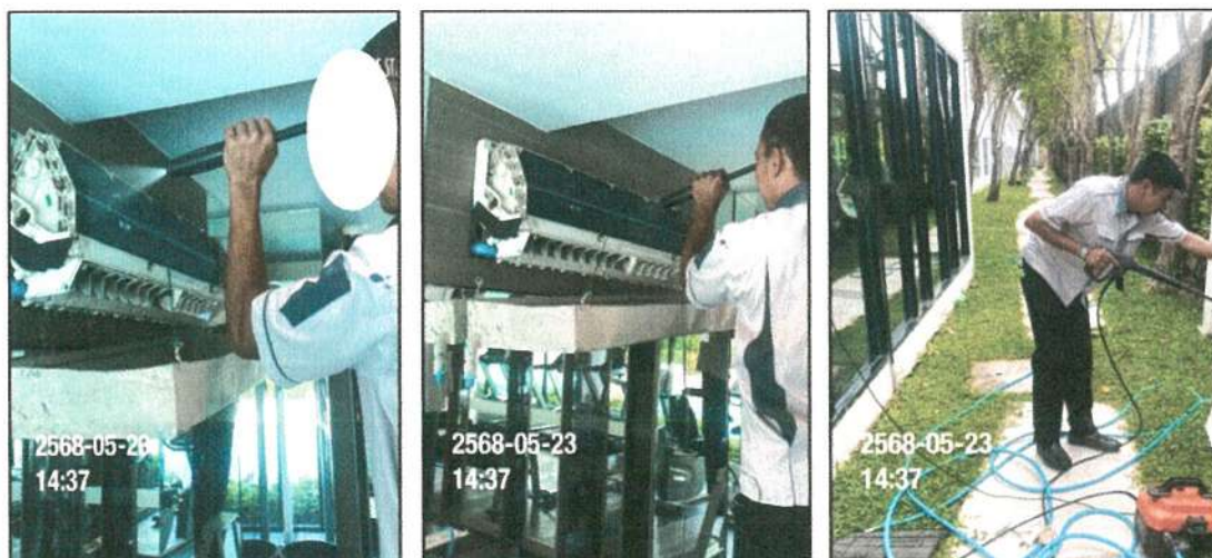
รูปภาพที่ 2.20 การล้างทำความสะอาดเครื่องปรับอากาศ
