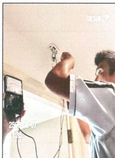
รูปภาพที่ 2.48 การตรวจสอบอุปกรณ์ป้องกันและแจ้งเตือนอัคคีภัย
